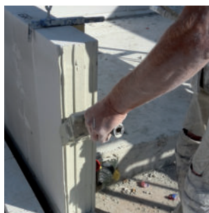
9 Ortbeton darf keinen Kontakt zum Kalksandstein haben. PE-Folie verwenden oder den Richtlinien der Statiker folgen.
