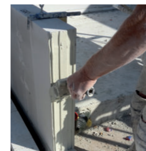
9 Ortbeton darf keinen Kontakt zum Kalksandstein haben. PE-Folie verwenden oder den Richtlinien der Statiker folgen.
