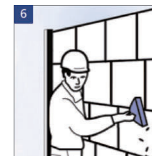
6 Herausquellenden noch nicht völlig abgebandenen Dünnbettmörtel mit einem Breitspachtel abstechen.
